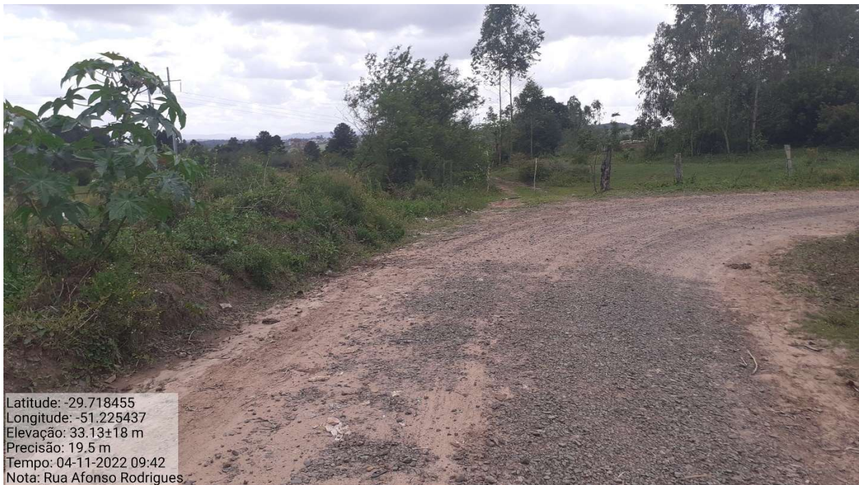
Foto 3: Rua Afonso Rodrigues – Fim do trecho
