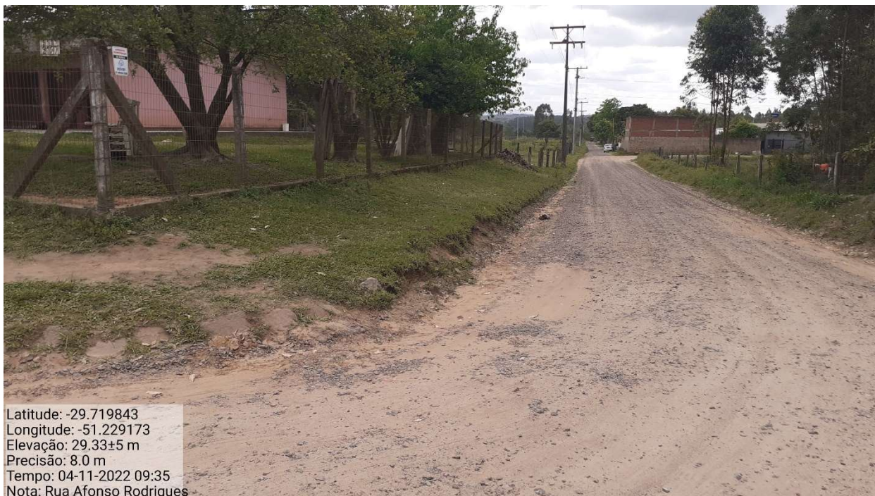
Foto 1: Rua Afonso Rodrigues – Início do trecho
