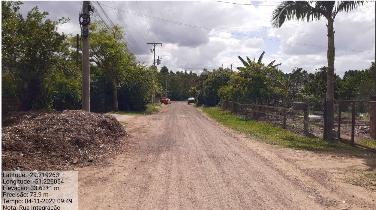
Foto 5: Rua da Integração – Meio do trecho
